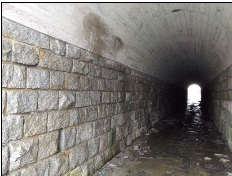
Obr. č. 9 - pohled na lokální průsaky vody skrze NK
