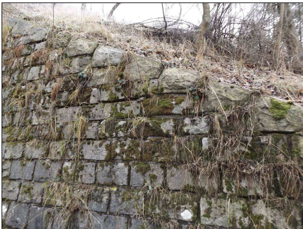
Obr. č. 8 - pohled rozvolněné kamenivo v horní části vybraného křídla objektu
